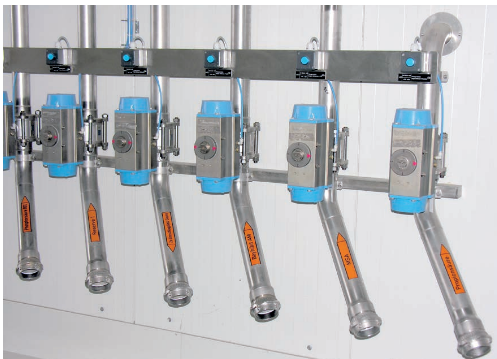
Abb. 6 Abfüllstelle bei einer ortsfesten Tankanlage (Firma Halag, Kt. Thurgau)
