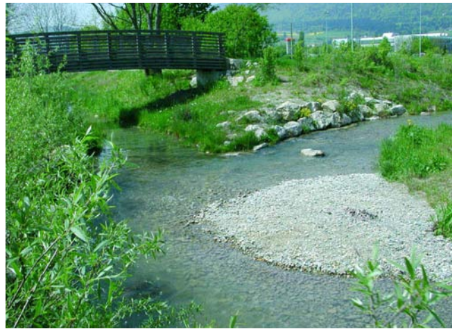
Die neue Einmündung des Dorfbaches in den Witibach. Die Brücke verbindet die Sportanlagen beidseits des Baches.
