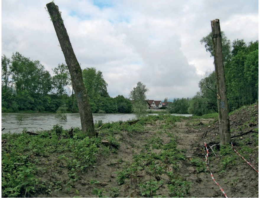
Frisch gerodete Fläche im Los 3. Die noch stehenden Baumstämme werden später als Kleinstrukturen ins Flussbett eingebaut.
