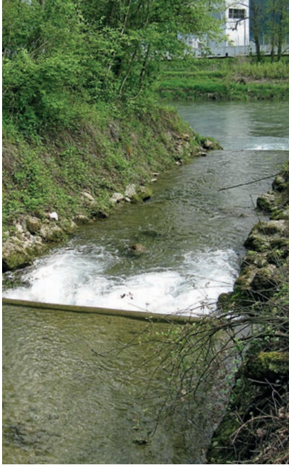
Heutiger Zustand des Stegbaches.
