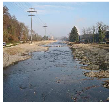
Nach der Aufweitung bildet sich ein dynamisches Gerinne mit Kiesbänken und abwechslungsreichen Fließ- und Strömungsmustern (Bild rechts).
