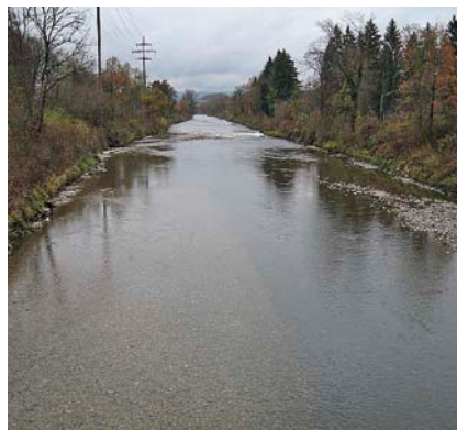
Nach der Aufweitung bildet sich ein dynamisches Gerinne mit Kiesbänken und abwechslungsreichen Fließ- und Strömungsmustern (Bild rechts).
