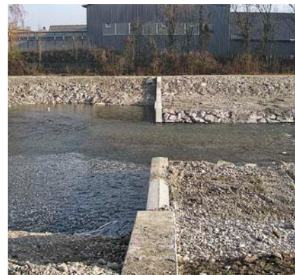
Die neue Blockrampe ermöglicht allen Fischen den Aufstieg (Bild rechts).
