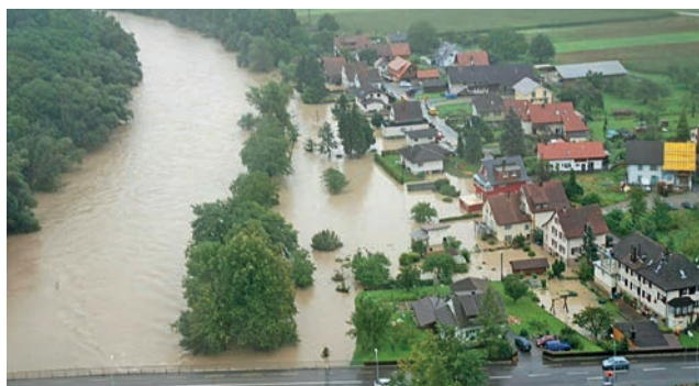
Hochwasser 2007 in Obergösgen
