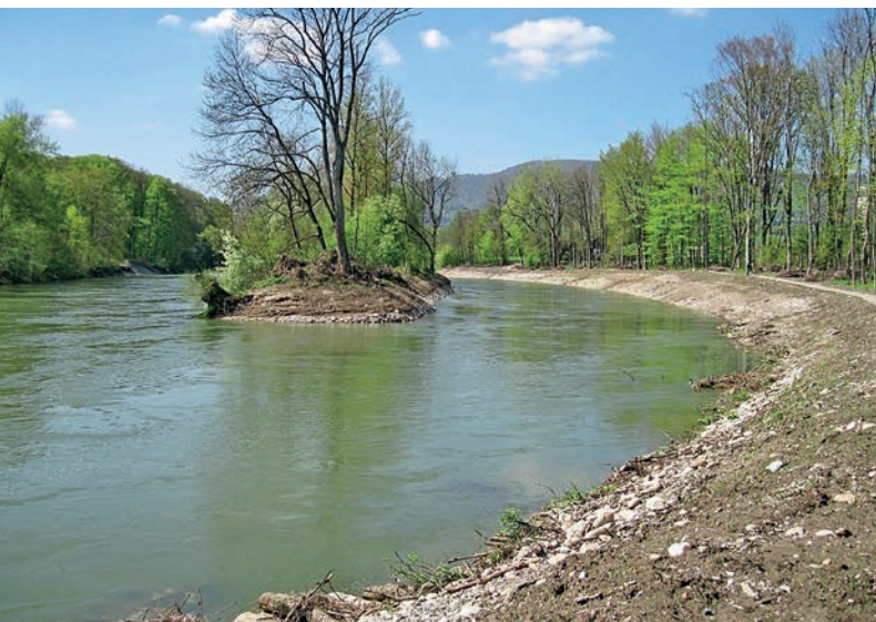
Hochwasserschutzprojekt an der Aare: Neue Seitengerinne erhöhen die Abflusskapazität.
